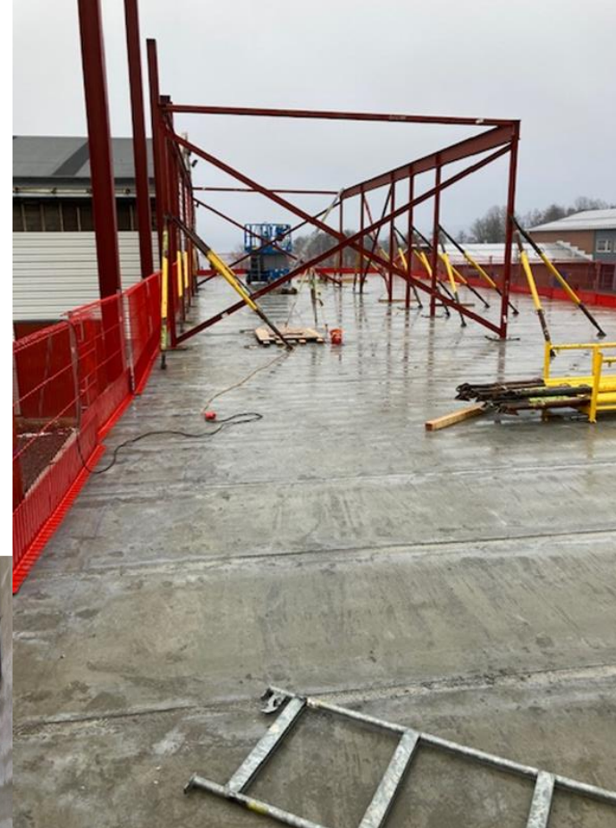
Trappeløp er på plass og 2 etg er under oppføring
