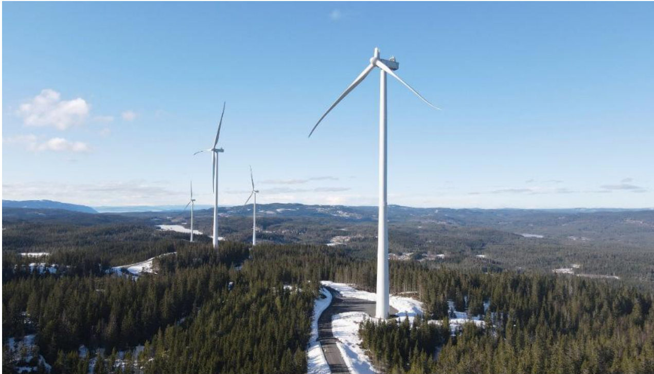
SYNLIG: Turbin nummer 9 på Engerfjellet repareres og skal snart i drift igjen. Foto: Odal vindkraftverk
