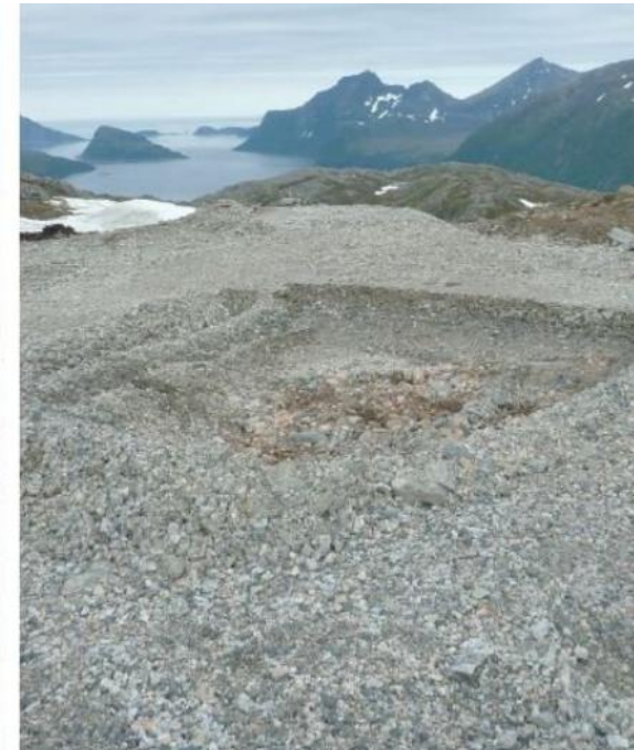
MÅTTE GRAVES UT: Her er områdene sanert. Etter at prøver viste at all forurensing var gravet ut, ble det fylt inn rene masser. Foto: Multiconsult
